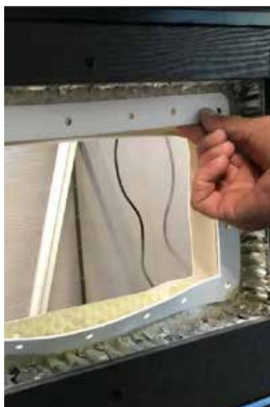
Enfin, il suffit de coller le joint intérieur de la buse de refoulement et du projecteur.
