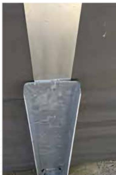
Intercaler la planche composite livrée dans le kit entre le profil de jonction et le sabot métallique.
