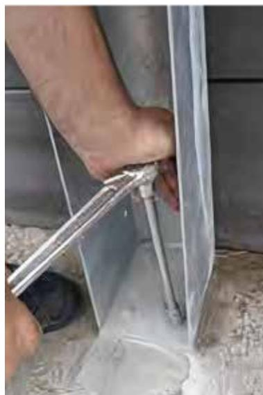
L'espace entre les panneaux et les colonnes est normal. Quand la piscine est remplie d'eau, les panneaux toucheront les colonnes en raison de la force de l'eau.
